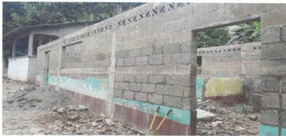
Foto 1: colocacion de pared del aula.
