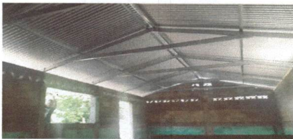
Foto 5: colocación de lámina
